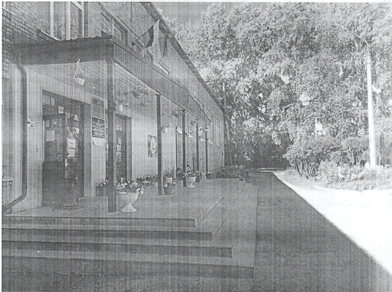
Фото №1. Центральное крыльцо (ремонт).
